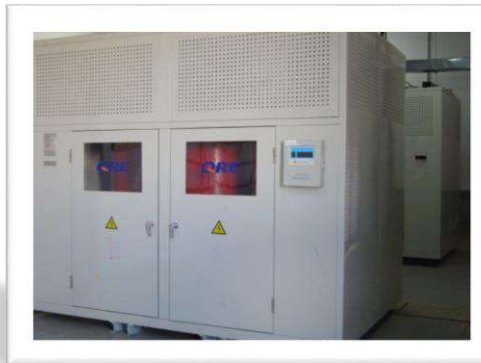
2000кВА 11/0.4кВ Сухой трансформатор, Foxcon
