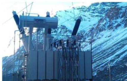
25MVA, 13.8/230kV, Силовой трансформатор, Чили
