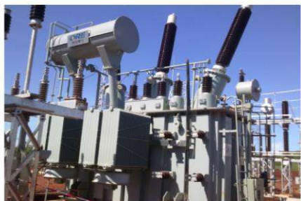
18/23MVA, 230/34.5kV Силовой трансформатор, Кения
