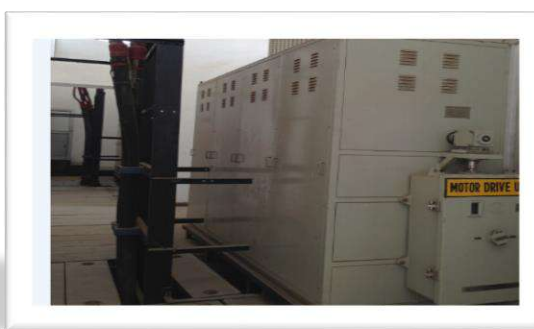
20MVA, 33/11кВ, Сухой трансформатор, TATA
