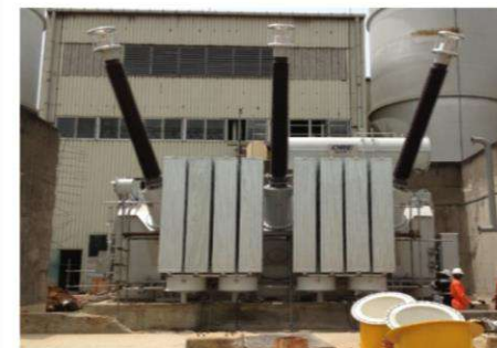
178MVA, 330/11.5kV Силовой трансформатор Нигерия GE
