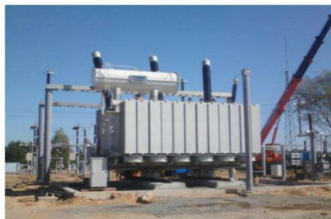
125MVA 330/11kV Силовой трансформатор, Беларусь
