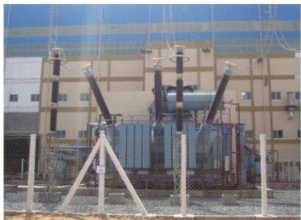
180MVA, 420/15.75kV Силовой трансформатор, Индия
